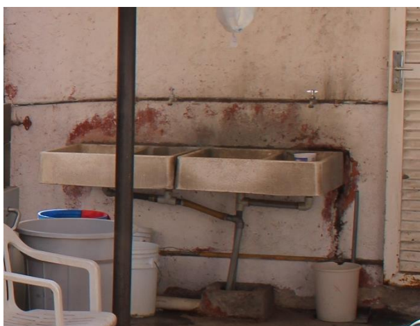
Cambio de tubería y drenaje de lavaderos
