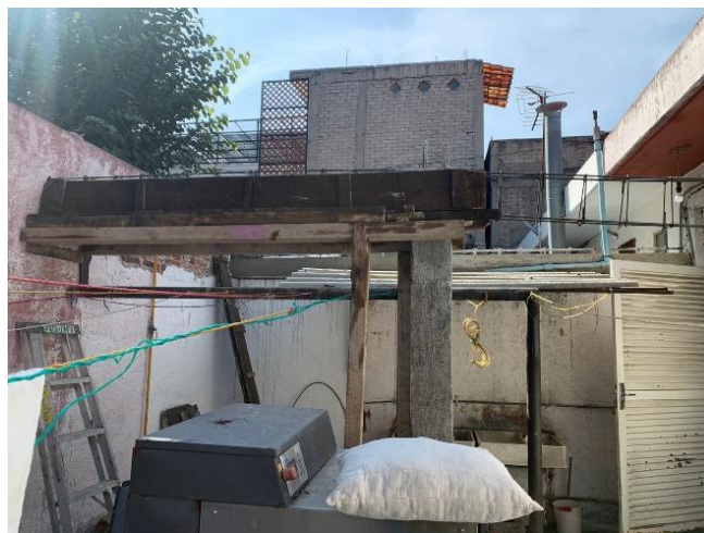
INICIO DE OBRA
